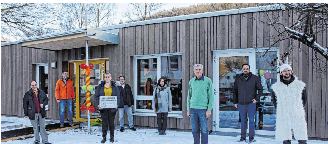
Die Holzmodule für die Erweiterung des Kindergartens Sennfeld kamen schon im November – nun wurde das Gebäude offiziell eingeweiht. Mit dabei waren Kindergartenleiterin Tatjana Felch (Dritte von links), Pfarrer Dr. Markus Roser (grüner Pullover) und Bürgermeister Wolfram Bernhardt (rechts). BILD: NICOLA BEIER
