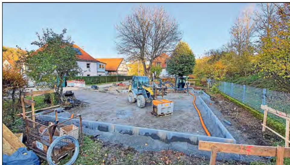
Die Firma Heizmann aus Osterburken bereitet gerade die Bodenplatte für das neue Gebäude am Sennfelder Kindergarten vor. Fotos/Repro: Jörg Zimmermann
