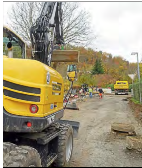
Die Arbeiten an der Straße am Kindergarten bedeuten eine große Herausforderung.
