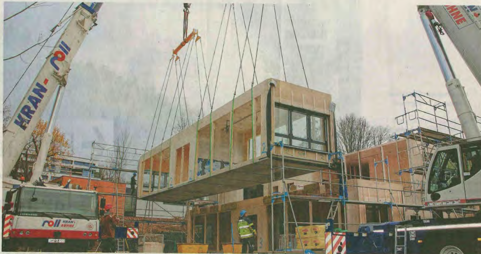
Die Kräne hieven die Klassenzimmer vom Tieflader, im Hintergrund das bestehende Gebäude des Eduard-Mörrike-Gymnasiums.
