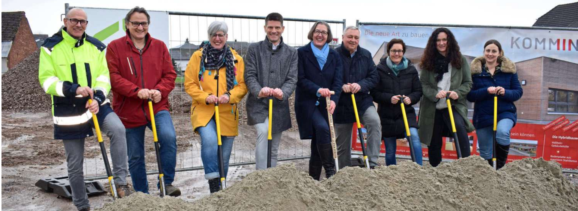
Auf die Spaten, fertig los: In Lauf gaben Vertreter der Gemeindeverwaltung, des Gemeinderates, der Pfarrgemeinde, der Kindergärten und der Baufirma den Startschuss für den Bau der neuen Kinderkrippe St. Anna. Foto: Michaela Gabriel
